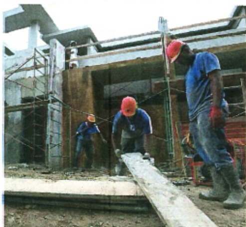
ACTUALMENTE unos 500 obreros trabajan en el proyecto del Dorado Beach que llevará el sello de Ritz-Carlton Reserve.
